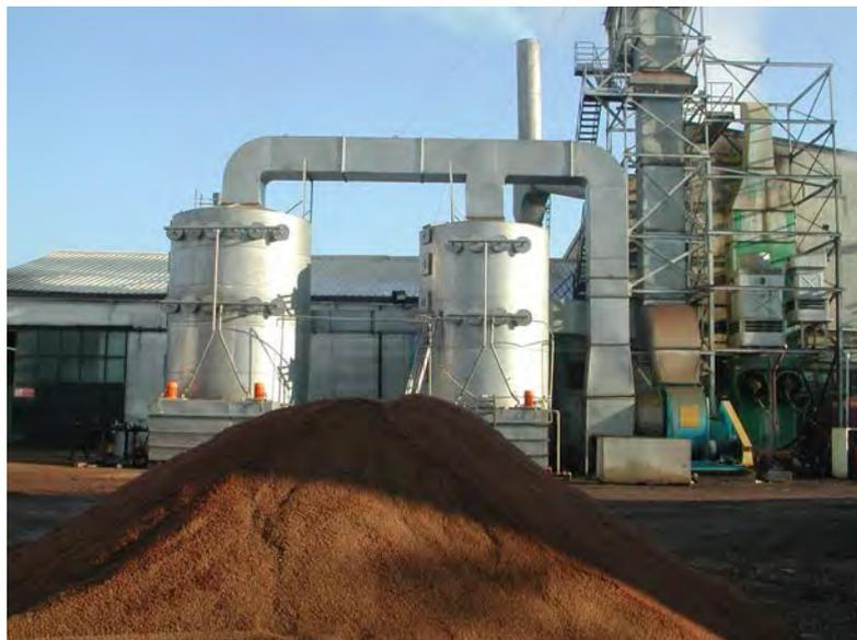
Le torri di lavaggio sono realizzate in acciaio inox in quanto la temperatura di esercizio a valle degli essiccatoi si aggira attorno ai 60 °C.
